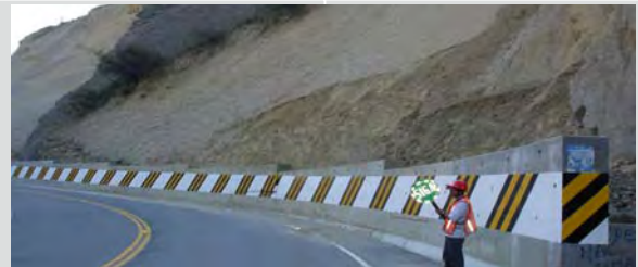
La protección de la carretera frente a derrumbes demuestra que esta fue construida considerando criterios de seguridad y calidad.
